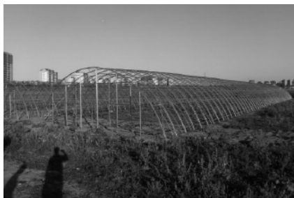
写真7：トルコギキョウ栽培のため パイプハウスを建設中（7棟）
