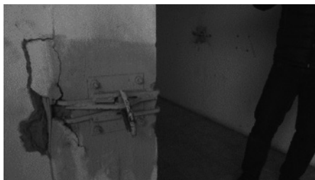
柱に補強の鉄を巻いている状態
