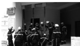
天井の崩落を抑える
