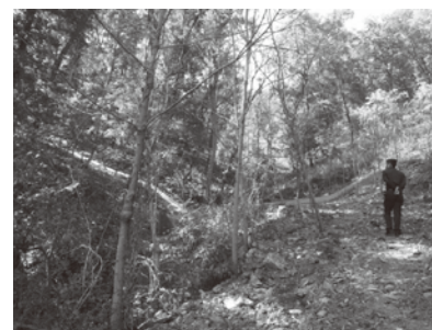
写真7 量水堰の山側
