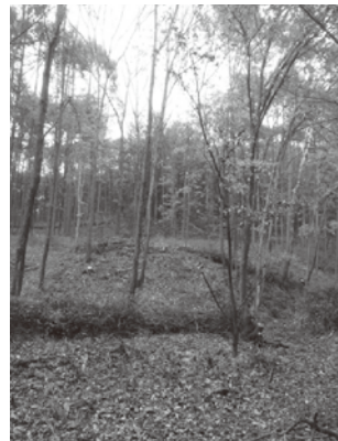
写真13 枝葉を用いた土砂流出対策
