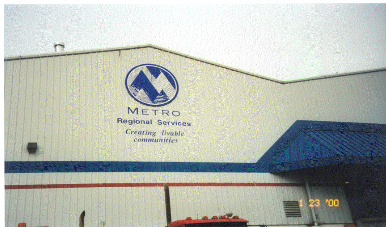
〈メトロ廃棄物中継施設〉
