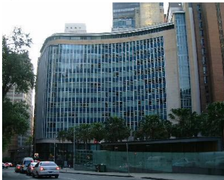
写真1 現代のヘリテージ。カンタス・ビル(シドニー市)
