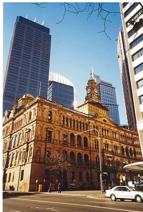
写真3 現代の高層ビルの谷間で存在感あふれる州政府の建物 （シドニー市）
