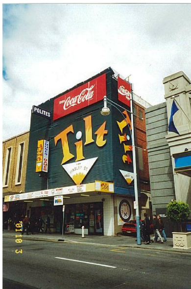
写真9 商業看板に隠されたレンガ 建築（アデレード市）
