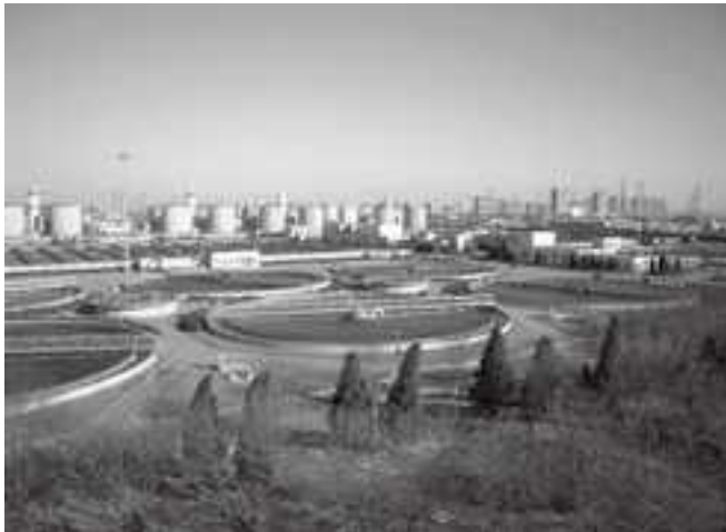
北京市にある高碑店汚水処理場では日本製の機材も多く導入されている
