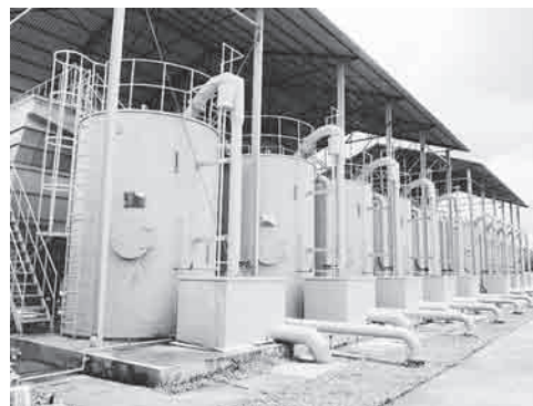
ビエンチャン郊外のベトナム企業建設・運営浄水場
