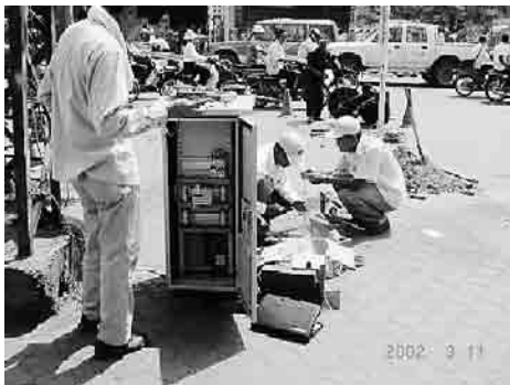
公社職員と共にテレメータを設置
