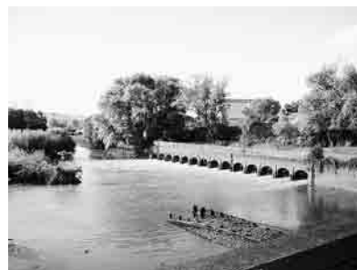
1868年に建設されたアビーミルズ揚水場 (テムズ・ウォーター提供)
