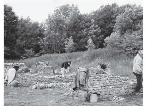
地元伝統技術の石壁作りの検定試験
