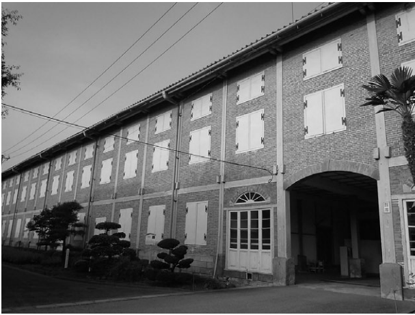
富岡製糸場東繭倉庫
