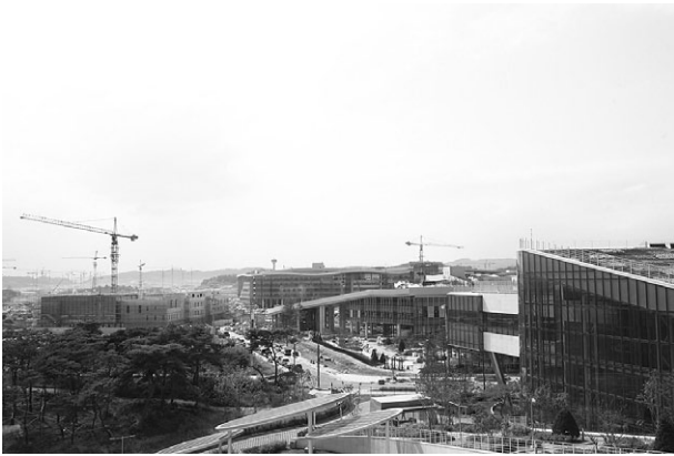
建設中の世宗市の様子（写真提供：行政中心複合都市建設庁）
