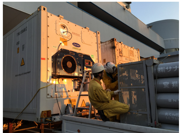
窒素ガス充填作業 ([MAXTEND]を用いることでリーファーコンテナをCA化できる)
