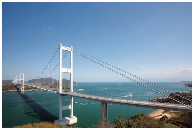
しまなみ海道（来島海峡大橋）
