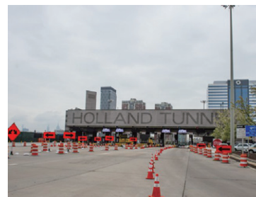
トンネルにおける検問所
