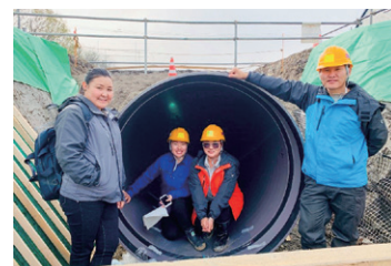
LGOTP で、建設技術研修員らとの現場視察の様子
