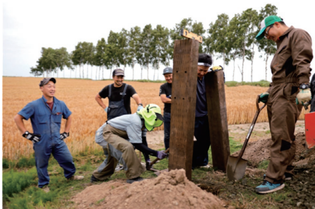
プロジェクト初の看板の設置作業はメンバー全員で行った
