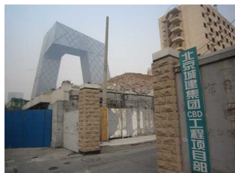
メディア産業回廊開発が進む朝陽区CBD (北京城建集团CBD建設プロジェクト現場)
