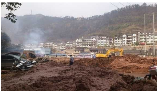
〈写真 16〉 移転工事が進む茅台鎮内
