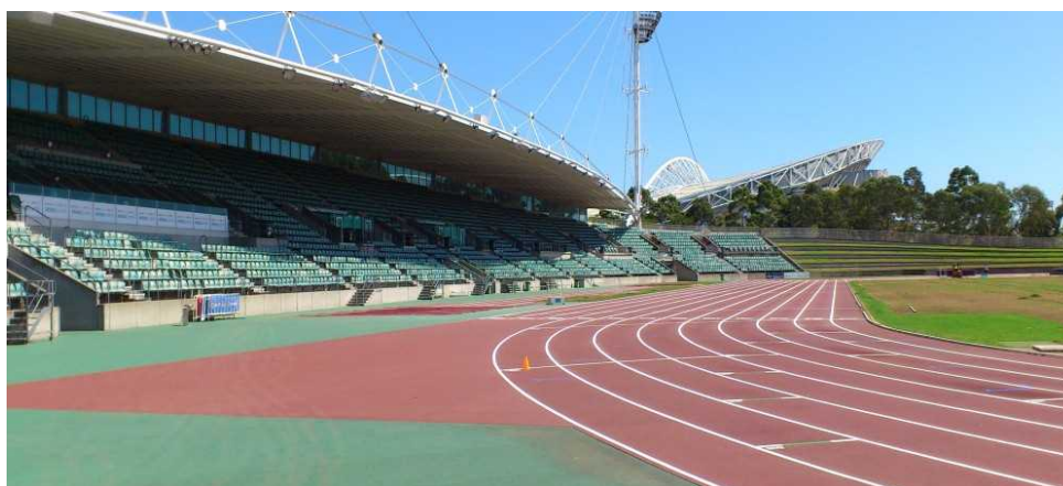
図 1－15 現在の陸上競技場（第 1 競技場）の様子 52
