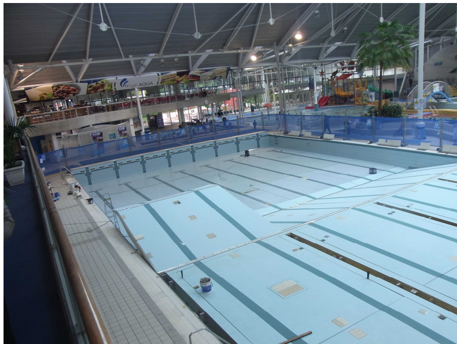
図 1-11 0～2.5mまで水深が調整可能な床 43
