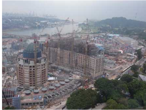
【建設中のリゾート・ワールド・セントーサ】
