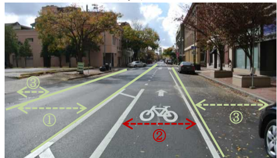
Baronne Street では、自動車走行帯2車線を1車線(①)に減らすことで、自転車レーン(②)の仮設スペースを確保している。道路両端の駐車帯(③)は残されている。(黄緑色実線は、従前の自動車走行帯を示す。)
