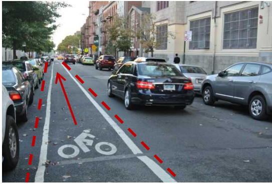
ニューヨーク市内「Class 2」参考例。写真左側の駐車帯に隣接し設置されている。白線により自動車の走行帯とは区別されている。自動車が駐車帯へ出入りする場合を除き、自動車は侵入しない。
