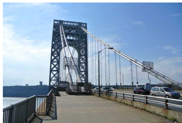
ジョージ・ワシントン橋自転車レーンの様子① 写真手前側がマンハッタン区、ハドソン川を挟み対岸がニュージャージー州。
