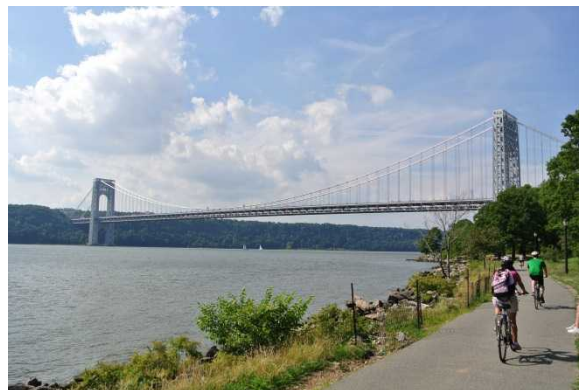
ジョージ・ワシントン橋外観。橋の南側に自転車レーンが設けられている。写真手前がマンハッタン区、ハドソン川を挟み対岸がニュージャージー州。
