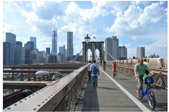
ブルックリン橋自転車レーンの様子①。写真右側が自転車レーン、左側が歩行者レーン。
