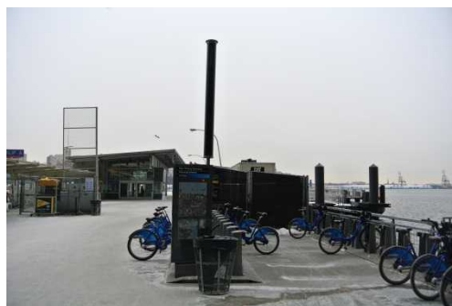
降船ターミナル（写真左奥）付近の様子。自転車レーンと接続し、「Citi Bike」の駐輪ステーションも設置されている。
