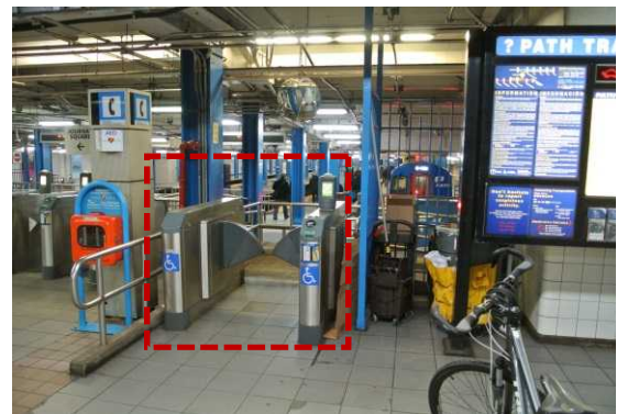
PATH-33St 駅改札ゲート外観
