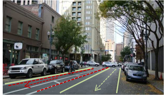
ニューオーリンズ市 Baronne Street の様子。従前は、道路奥方向(東)から手前(西)方向へ向かう自動車走行帯2車線と道路両端の駐車帯で構成される路線であった。(赤色破線内が仮設自転車レーン。黄緑色実線は、従前の自動車走行帯を示す。)
