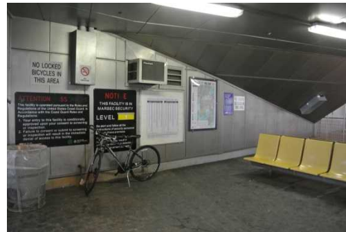
White Hall ターミナルの自転車待機場所（内部）
