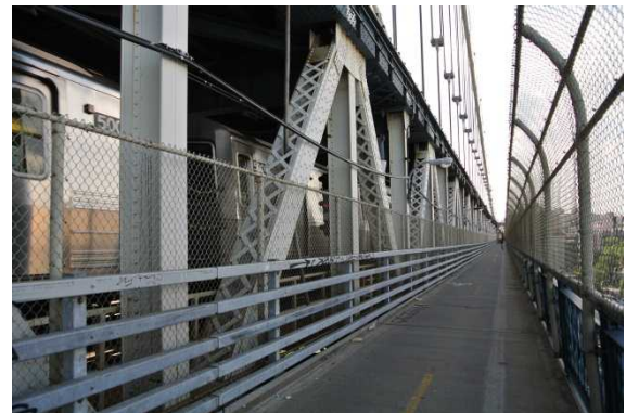
マンハッタン橋自転車レーンの様子②。通路中央の区画線（黄色破線）より左側が自転車レーン、右側が歩行者レーン。写真奥がマンハッタン（西）方向。
