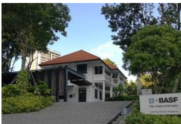
写真 37 オフィスとして利用されているバンガロー
