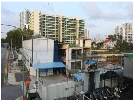
写真 41 現在の様子（プレハブ右手、 中央の建物が修繕中の旧建築物）
