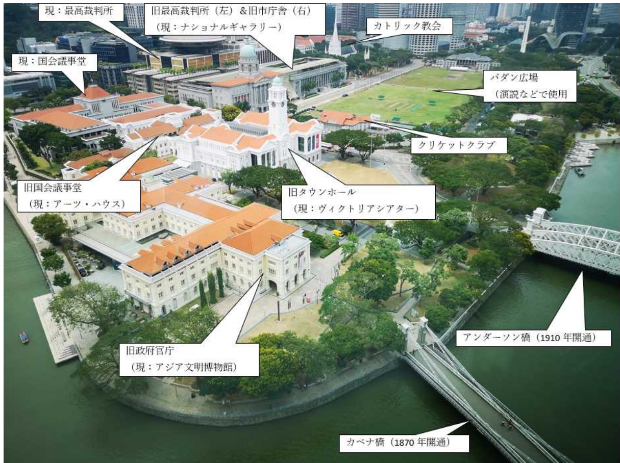
写真1 シティホール付近の旧政府機関の活用状況
