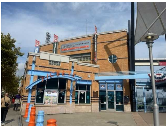
図2-7 Staten Island University Hospital Community Park (ニューヨーク市スタテンアイランド) の様子。(2024年10月4日筆者撮影) 独立リーグに所属するスタテンアイランド・フェリーホークスの本拠地。他球場に比べて規模は小さいが、コンサート、ユーススポーツ、大学イベント等が行われ、スタテンアイランドの文化活動の拠点の一つとなっている。
