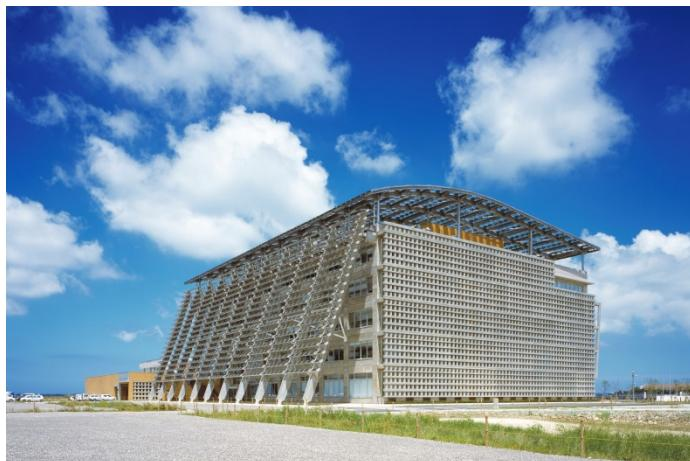
在南面及屋顶设置太阳能发电系统的市政厅建筑物 沖绳县糸满市
