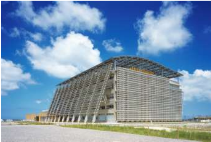
在南面及屋顶设置太阳能发电系统的市政厅建筑物 冲绳县糸满市
