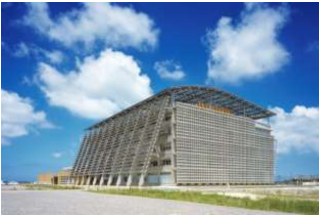
남쪽면, 옥상면에 태양광 발전 시스템을 설치한 시청사 - 오키나와현 이토만시
