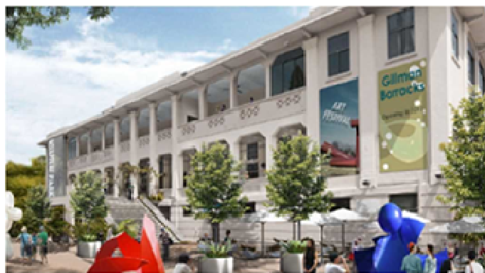
(図 3-13-12) ギルマンバラックス外観 1112
