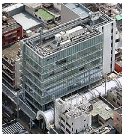
岐阜県国際交流センター外観
