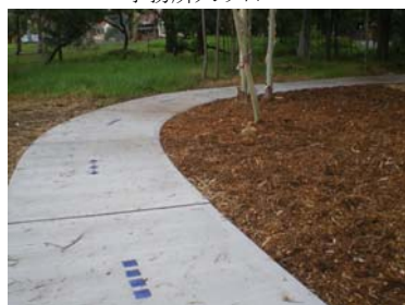
P & Cによる遊歩道の工事
